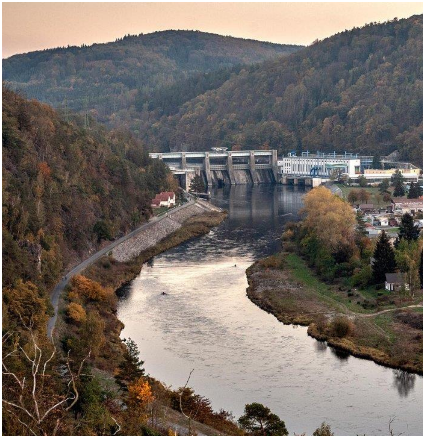
Elektrárna ve Štěchovicích
